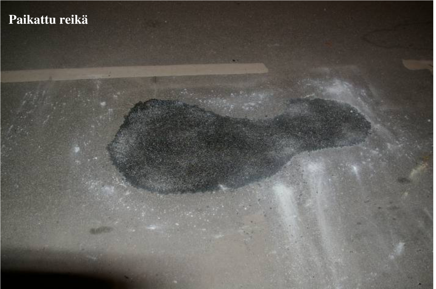
Paikattu reikä 10 päivän kuluttua
